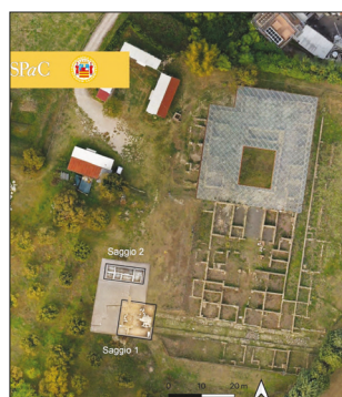
In basso a sinistra il nuovo edificio emerso isorientato con il decumano e la domus
